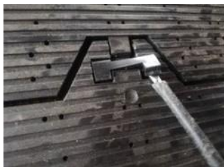
Рис. 22 Демонтаж фиксирующих заглушек отверткой
