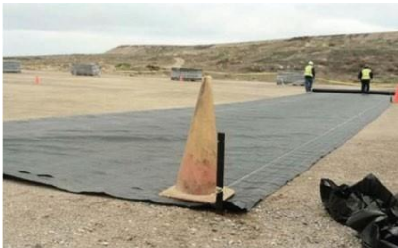
Рис. 10 Укладка геотекстиля
